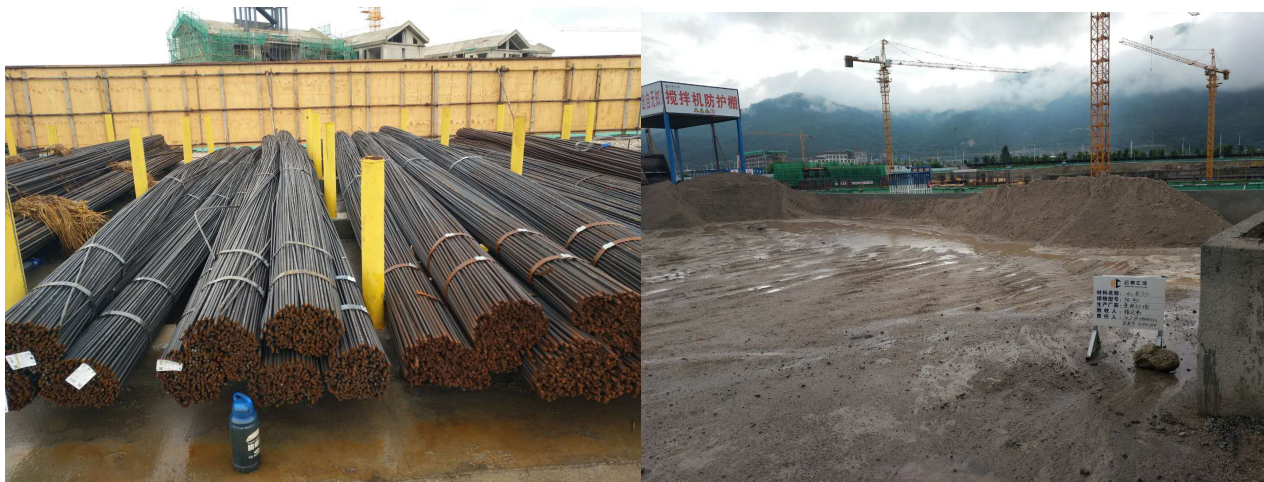
现场材料堆放实景图
