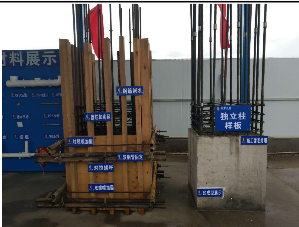
结构工序样板实景图
