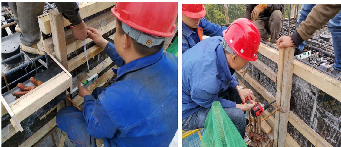
预埋件水平定位及外侧模板开孔
