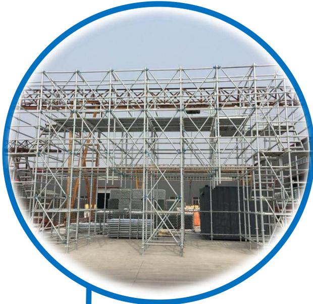
由圆盘式脚手架演变的产品，该产品于上世纪八十年代从欧洲引进，是**继碗扣式脚手架之后的升级换代产品**。又称菊花盘式脚手架系统，插盘式脚手架系统，轮盘式脚手架系统，扣盘式脚手架，雷亚架，因为该脚手架的基本原理是由**德国LAYER（雷亚）公司发明**。
